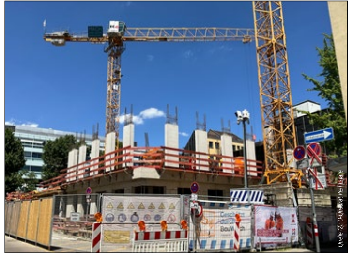
Aktueller Bautenstand des TWO.ONE von der Ecke Lange Straße/Calwerstraße.
