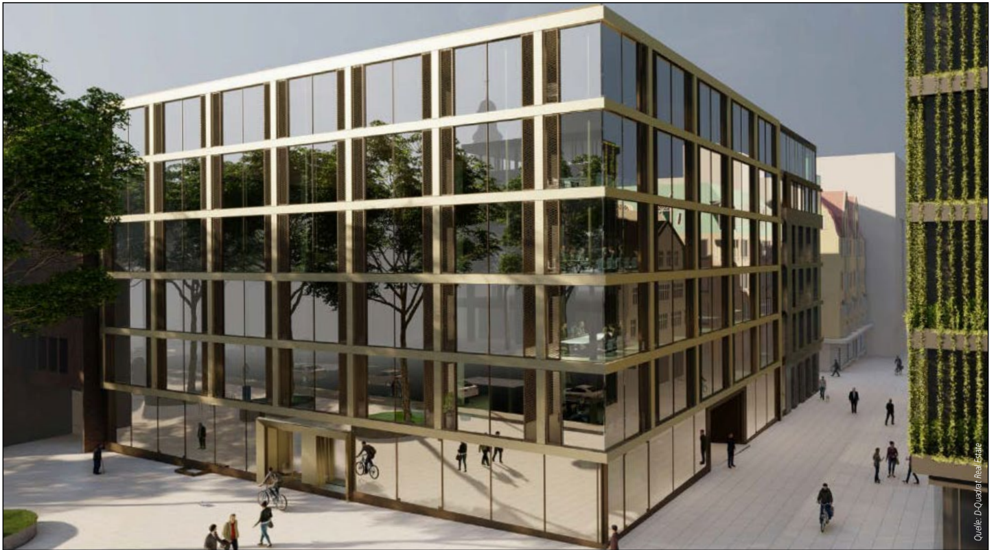
Das „Two.One“ wird später fertig als geplant – die Baustelle stand neun Monate still
